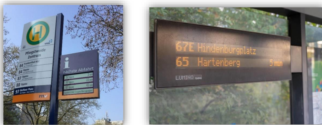
Abb. 22: Links in Haltestellenmast integrierte DFI (Ludwigshafen, Foto © rnv GmbH) und rechts in Rückwand des Wetterschutzes integrierte DFI der Firma Lumino (Mainz, Foto www.antenne-mainz.de)
