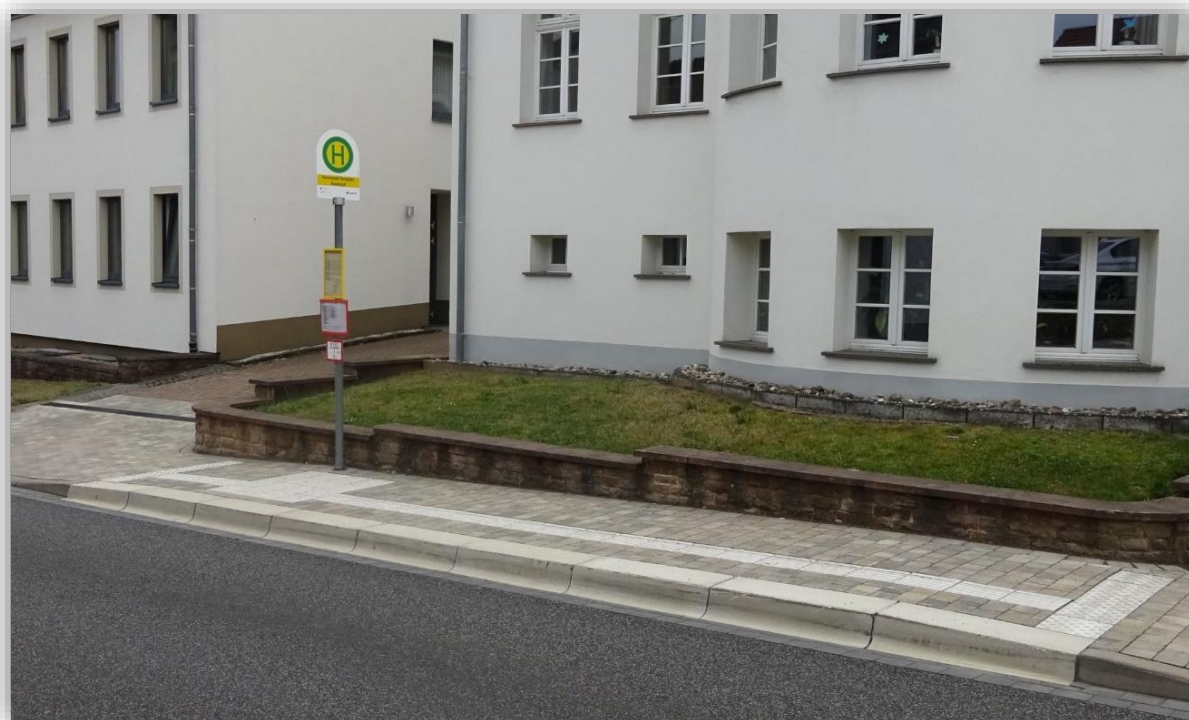
Abb. 16: Nonnweiler Dorfplatz, Beispiel einer barrierefrei ausgebauten Haltestelle, die den Mindestanforderungen genügt: Mast mit neuem Schild, Fahrplanaushänge, Hochboard, Taststreifen. Foto © ZPS, Markus Philipp.
